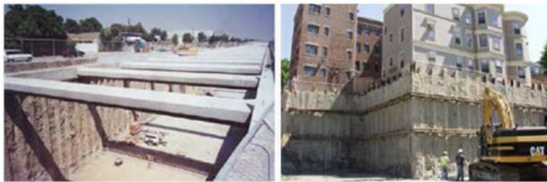
Figura 2.12: Raste të përdorimit të kolonave me çimento apo gëlqere si struktura mbështetëse kundër presionit anësor të dherave (përshtatur nga [Makusa, 2012])
